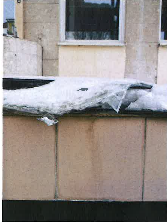
Zdj. 4 Widok na przybudówkę
