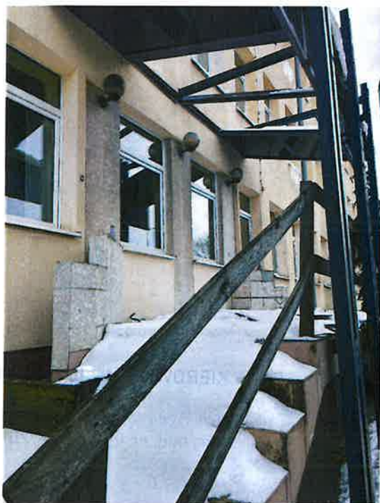
Zdj. 1 Widok na przybudówkę
