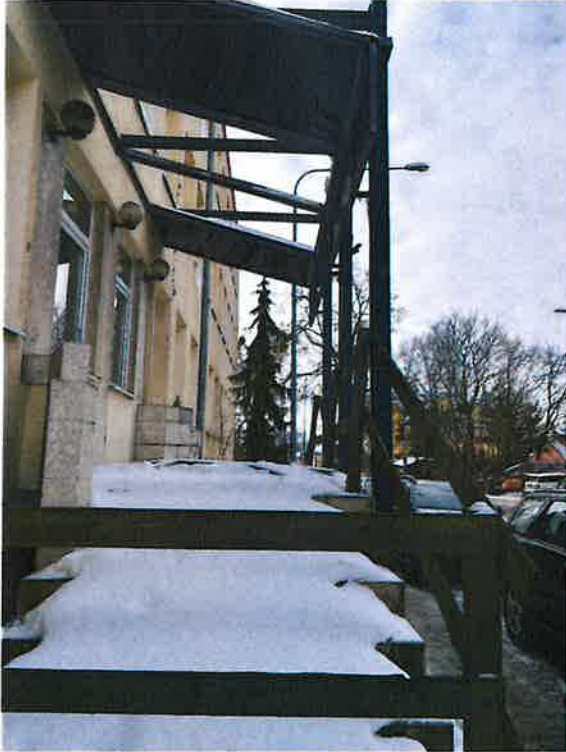
Zdj. 3 Widok na przybudówkę
