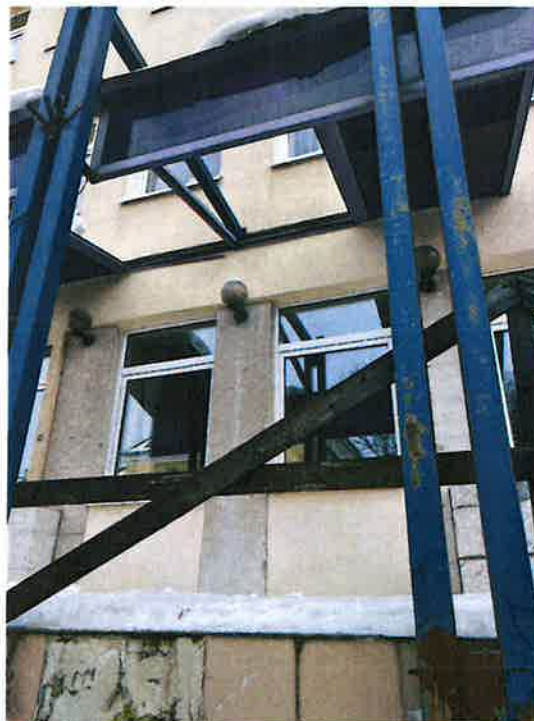
Zdj. 2 Widok na przybudówkę
