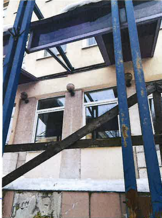
Zdj. 2 Widok na przybudówkę
