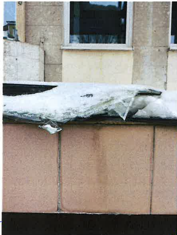
Zdj. 4 Widok na przybudówkę
