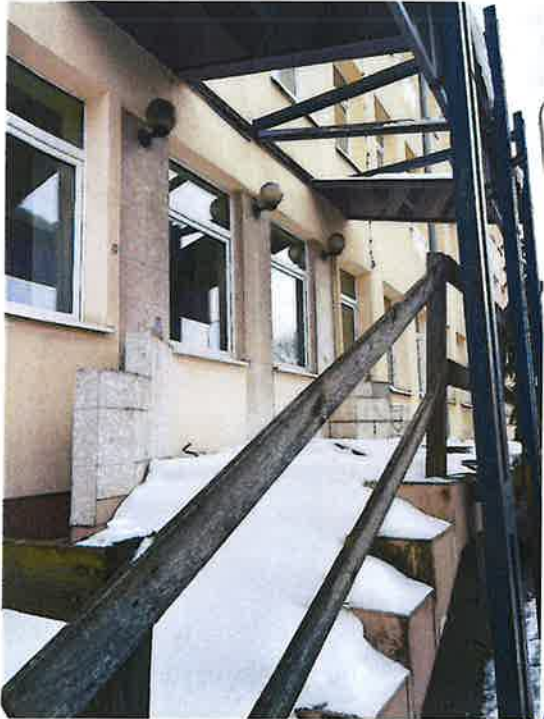
Zdj. 1 Widok na przybudówkę
