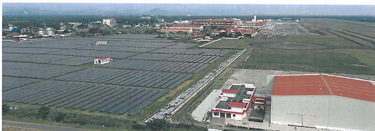
Rysunek 3 Instalacja farmy PV na międzynarodowym porcie lotniczym Cochin składa się z 46 150 paneli słonecznych, które są rozmieszczone na 45 akrach ziemi przy lotnisku [35][36]
