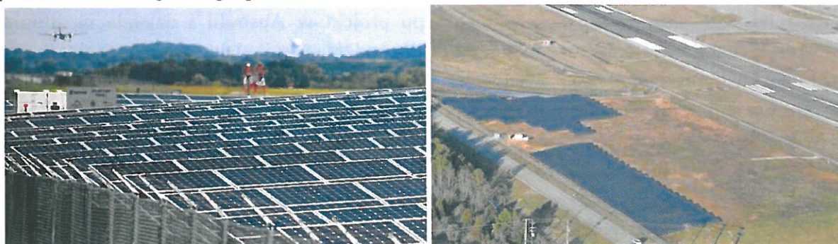
Rysunek 4 Instalacja PV na lotnisku Chattanooga Metropolitan [18]
