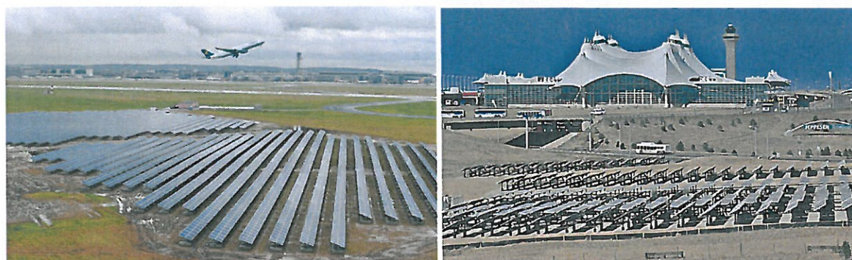
Rysunek 6 Instalacja PV na międzynarodowym lotnisku w Dusseldorfie [21] oraz na międzynarodowym lotnisku w Denver w USA [20]
