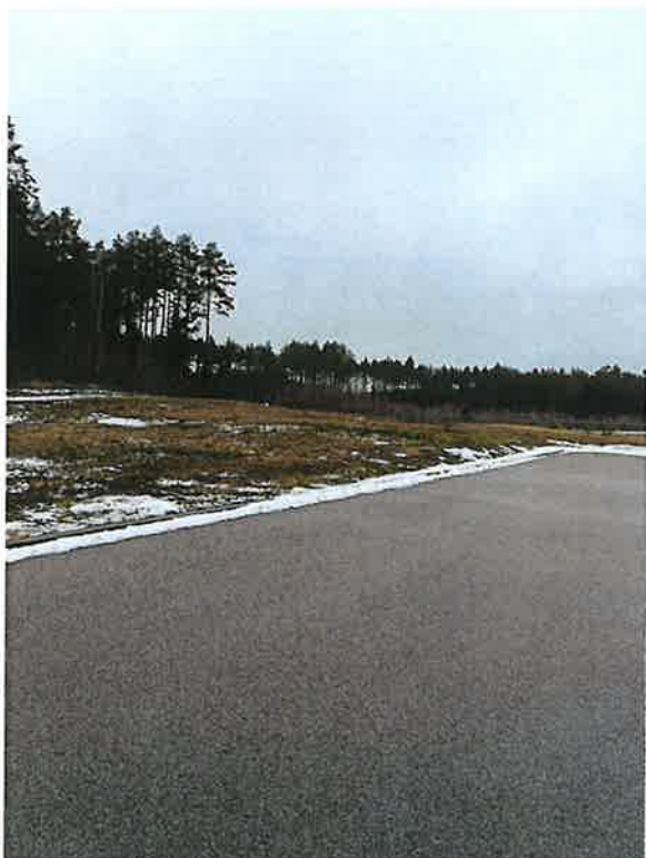
Zdj. 3 Widok na teren inwestycji
