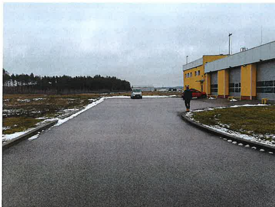
Zdj. 2 Widok na LSRG (po prawej) i teren inwestycji (po lewej) oraz plac manewrowy przed garażem
