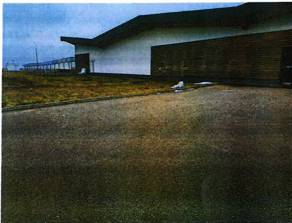
Rysunek 1. Widok na plac manewrowy i wiatę techniczną
